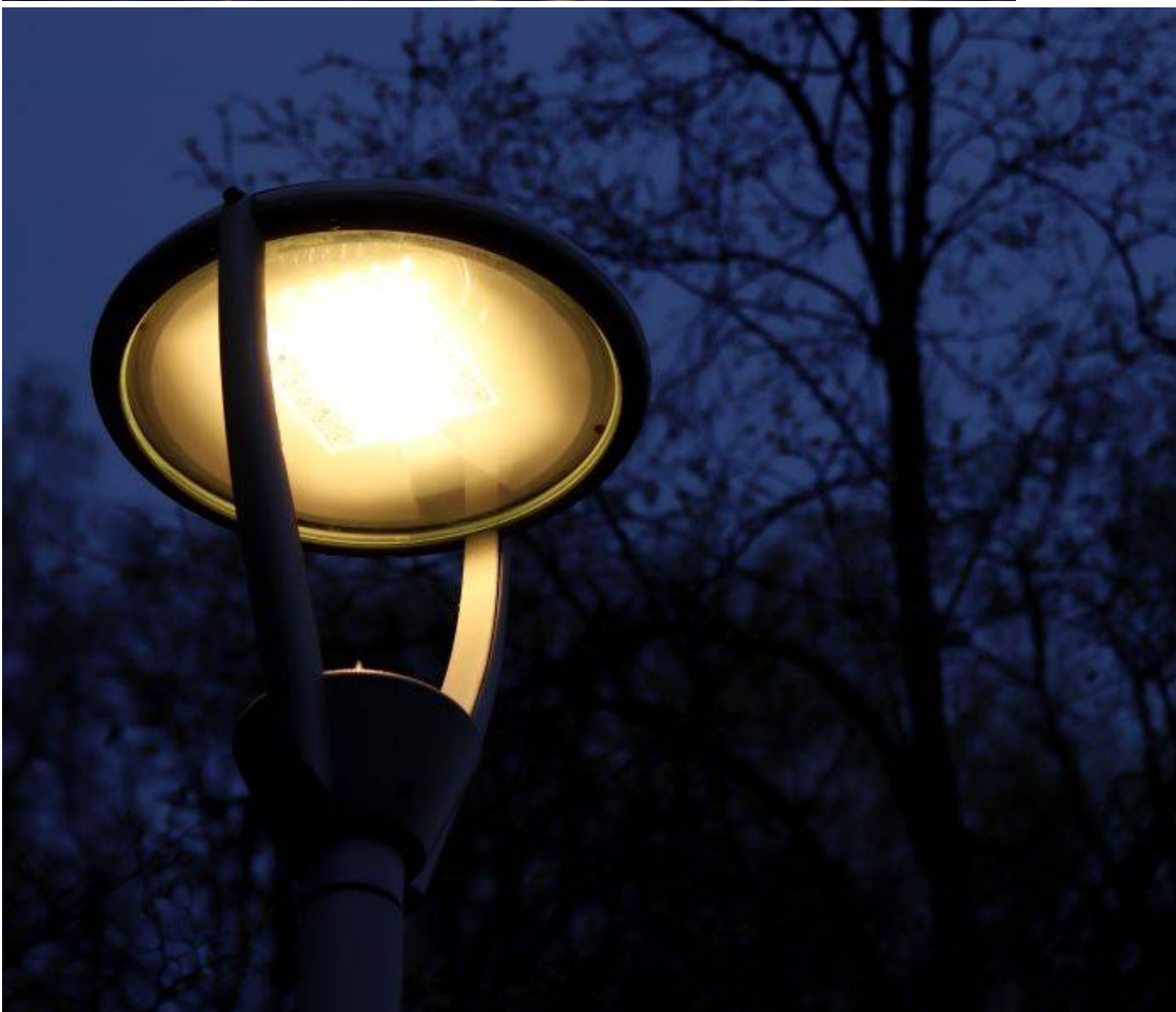
Le déploiement LED sur le parc d'éclairage public
