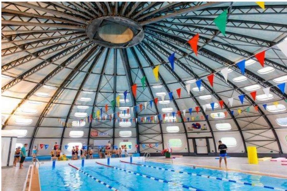
La piscine Tournesol est un modèle de piscine issu d'un programme national de construction de piscines de type industriel, qui a entraîné la construction de 183 piscines de ce type en France à la fin des années 1970 et au début des années 1980.
