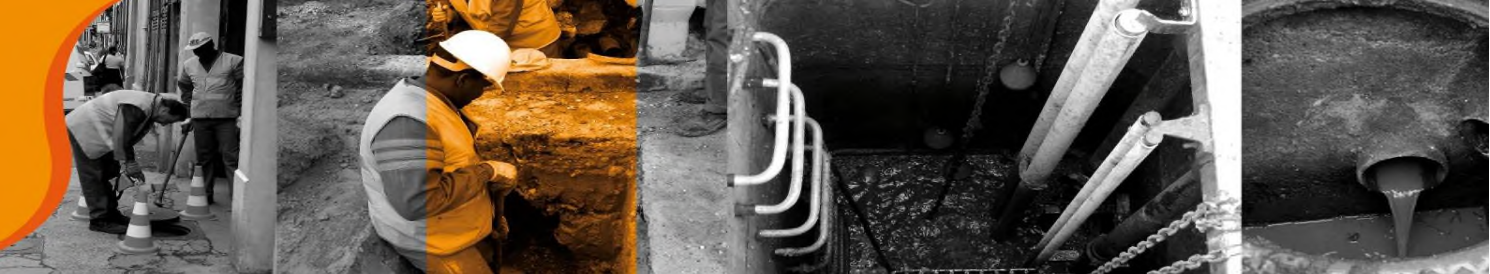
Listing des interventions par ouvrages et par type
