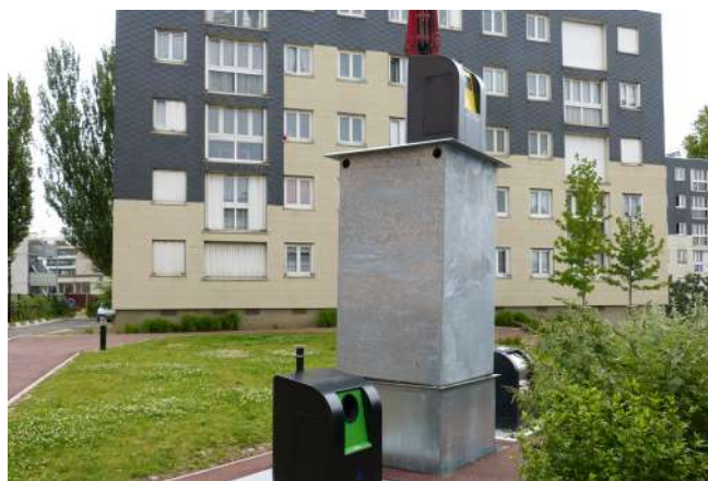
©Syndicat Emeraude / Maintenance des bornes enterrées
