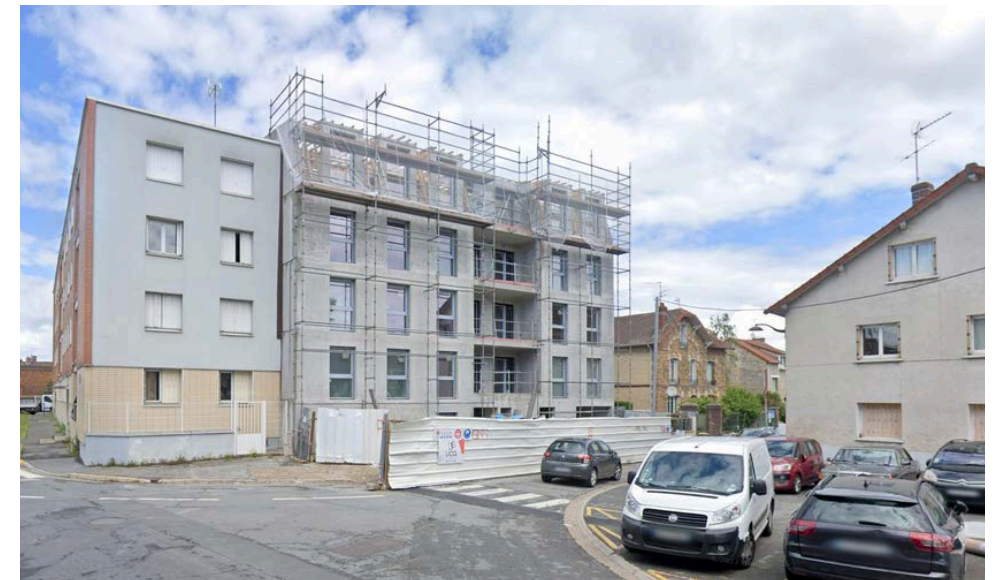
VUE OUEST DEPUIS LE PARVIS SUD DE LA GARE, RUE PASTEUR
