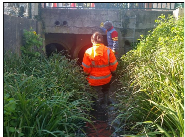
Ph2 : Vue du ru depuis l'amont
