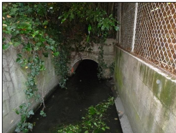
Aval – Vue de l'extrémité aval (PM8)
