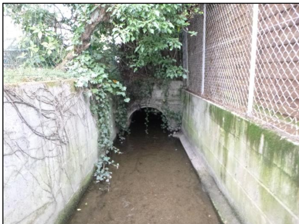
Connexion aval – vue générale
