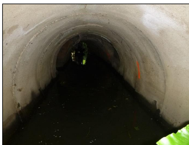
PM0 - Vue générale vers l'aval
