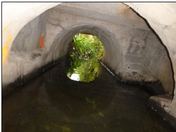
PM7,9 – Fissure longitudinale à 3h (2 mm)
