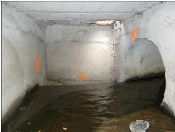
Ph3 : Vue vers la chute vers l'amont EP
