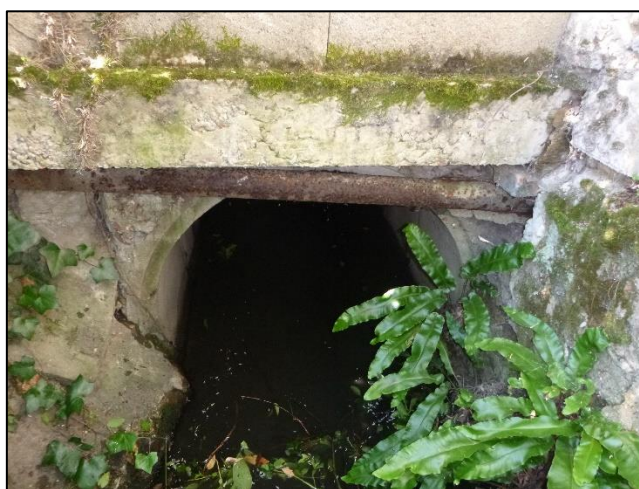
Traversée réseau ERDF extrémité amont
