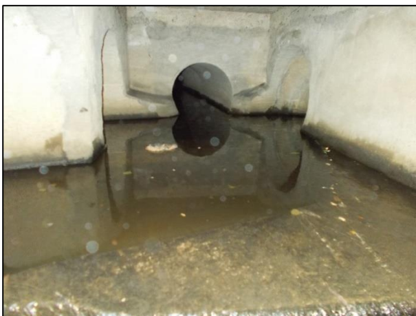
Ph1 : Vue depuis la chute vers l'amont EP
