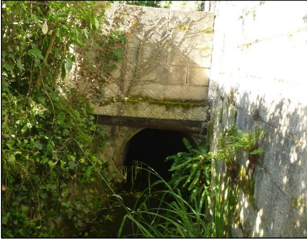
Aménagement végétalisé de la connexion amont – vue depuis l'amont
