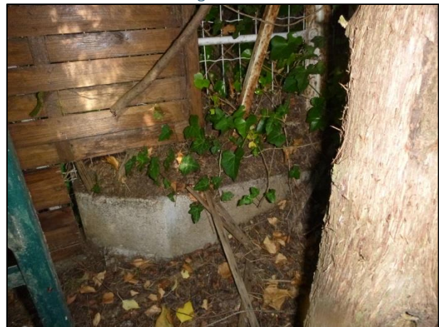
Vue depuis riverain côté gauche de l'extrémité aval : impact ouvrage sur clôture
