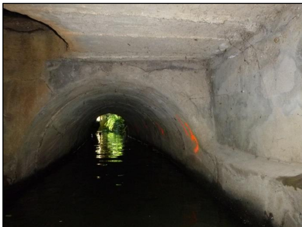
PM2 – Vue vers l'aval : zone rectangulaire au droit du regard
