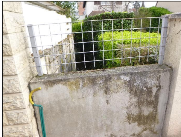
Accès amont – vue depuis la voirie
