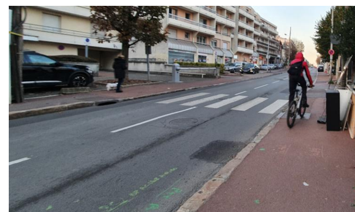
Trottoir étroit et conflit d'usage sur la RD909
