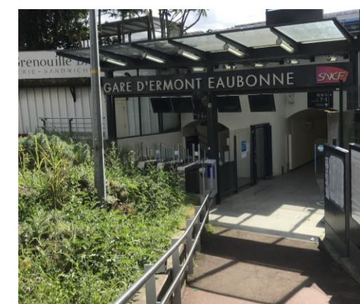
Accessibilité non PMR par l'accès rue des Calais
