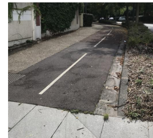
Des espaces piétons étroits le long de l'aménagement cyclable sur la RD470 (rue du Grand Grill)
