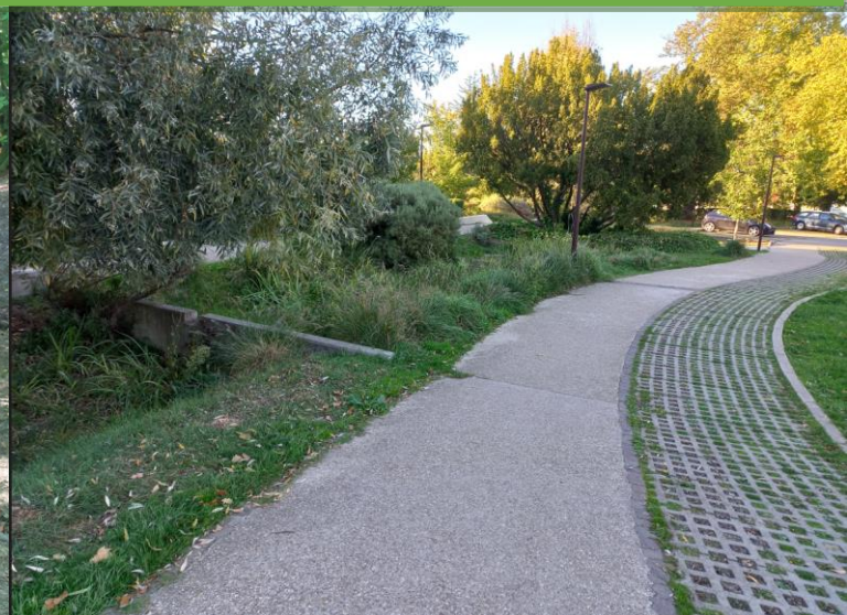
Noues et chemin de pavés – Parc de la mairie de Domont
