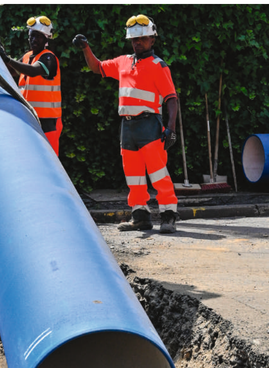
Chantier de renouvellement de Livry-Gargan (93)
