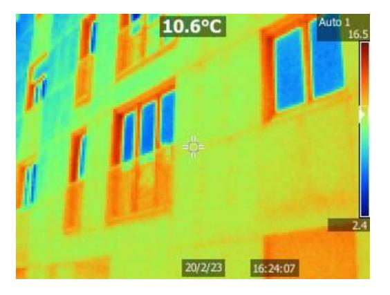
Les fixations des dalles créent également de multiples petits ponts thermiques comme les montrent les points sur l'isolant.
